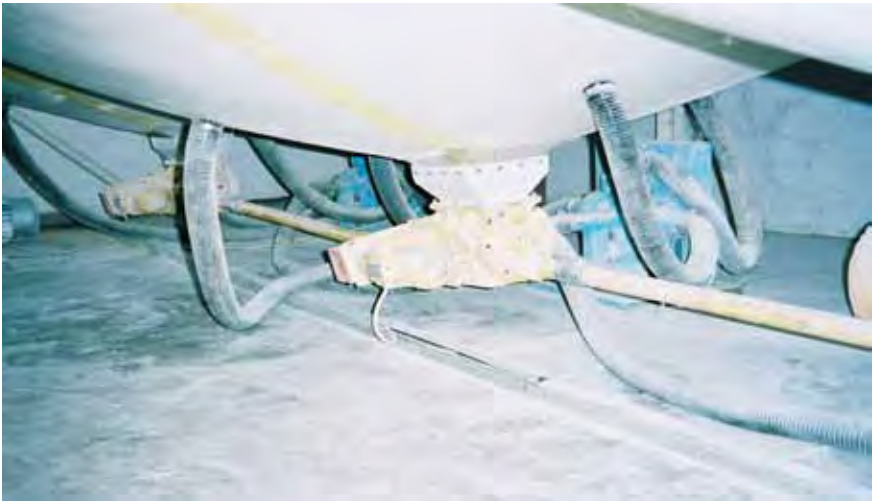
Abb. 3 + 4: Beispiele für „schlechte“ Reinhaltung des Siloraums [36]: Zone 22
